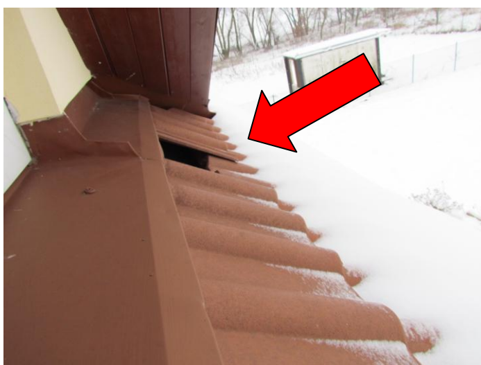
Tvorba tepelných mostů vlivem nesprávné aplikace tepelných izolací v místě pozednic – zřejmý nátěr po předchozí kondenzaci
